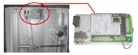
Figure 16. Novar® MINio Control Module
